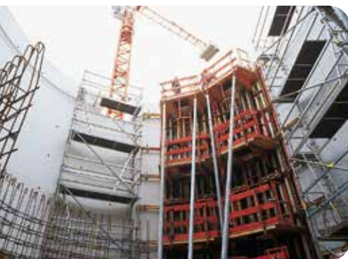
> Usine des eaux de Neuilly-sur-Marne
